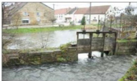
Le vannage de l'ancien moulin va être démonté.
