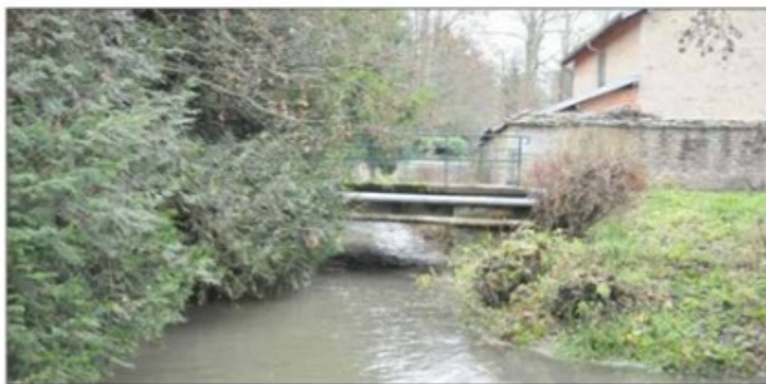
Ce pont enjambe la Bonnelle, il est la propriété de la commune. Sa refonte est du ressort communal.
