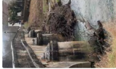
Des troncs d'arbres entiers s'accumulent contre les ouvrages. (Photos SMBMA).
