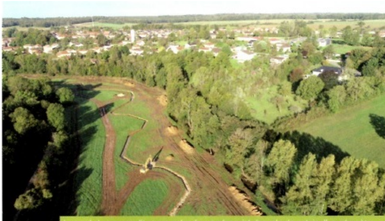
Le tracé du nouveau lit et ses méandres a nécessité des relevés précis d'un géomètre.
