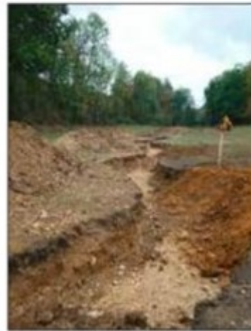
Le lit initial du cours d'eau a été rétabli.
