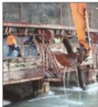
Une entreprise a dégagé le pont-barrage de l'usine Ferry-Capitain à Joinville-Bussy.
