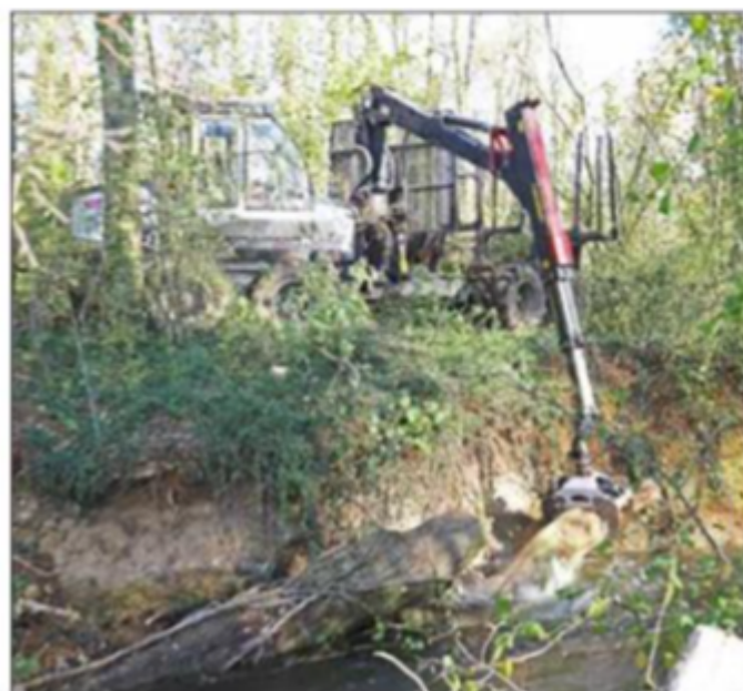
Le dégagement de la rivière a nécessité l'utilisation d'une grue.
