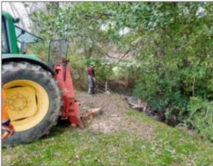
Un tracteur, équipé d'un treuil, a permis de remonter l'embâcle.
