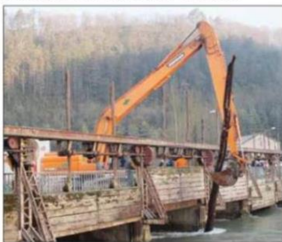
Une pelleteuse à bras long, équipée d'un godet, a permis de soulever un tronc d'arbre de près de 25 m immergé en travers du pont-barrage.
