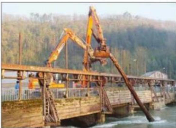
Une seconde pelleteuse, équipée d'une pince, a pris le relais du premier engin pour saisir et extraire la grume de la Marne, rivière qui traverse le périmètre de l'usine.
